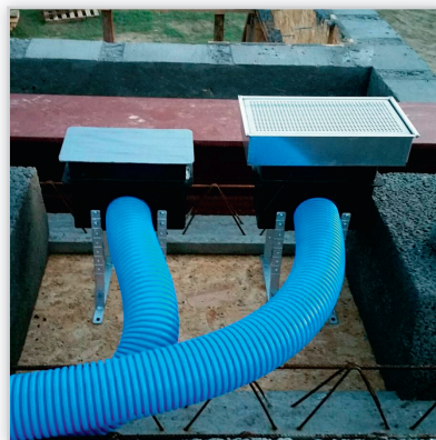
SPIDERvent® – skrzynki nawiewu podłogowego Precyzyjna regulacja położenia skrzynki rozprężnej nawiewu podłogowego.
